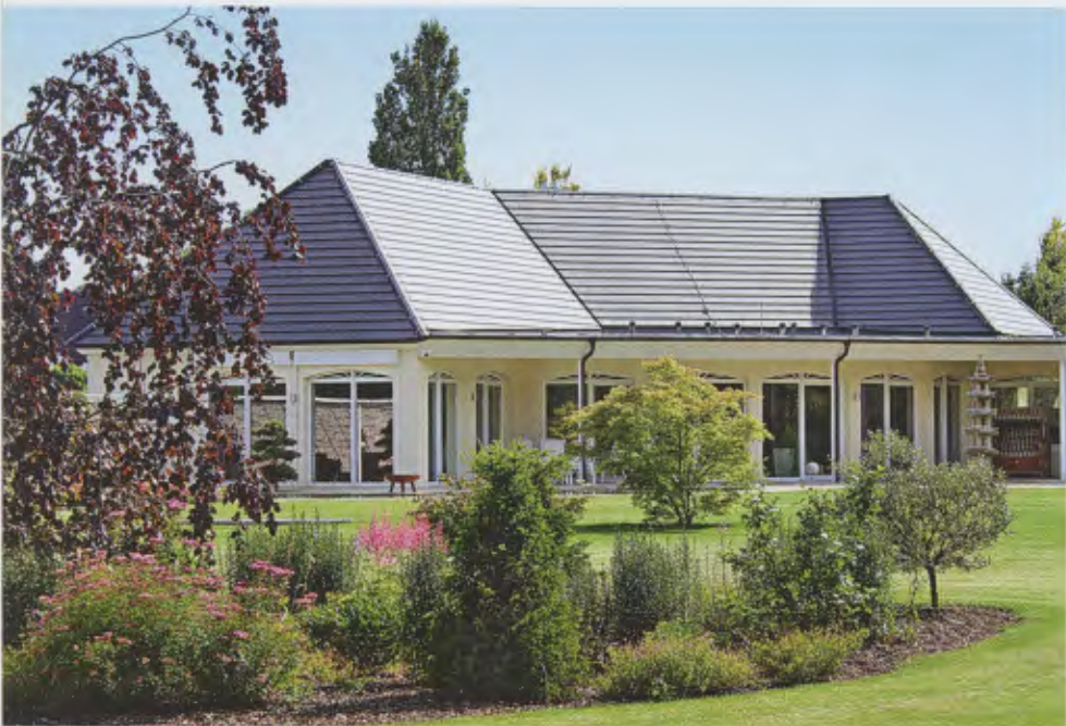
Blick auf den Neubau mit Schwimmbad: Ein großzügig angelegter Garten gehört ebenfalls zum Grundstück.
